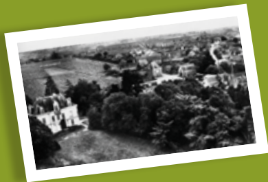
Vue du château de la Barre et du village d'Ardenay – View of the Château de la Barre and the village of Ardenay
