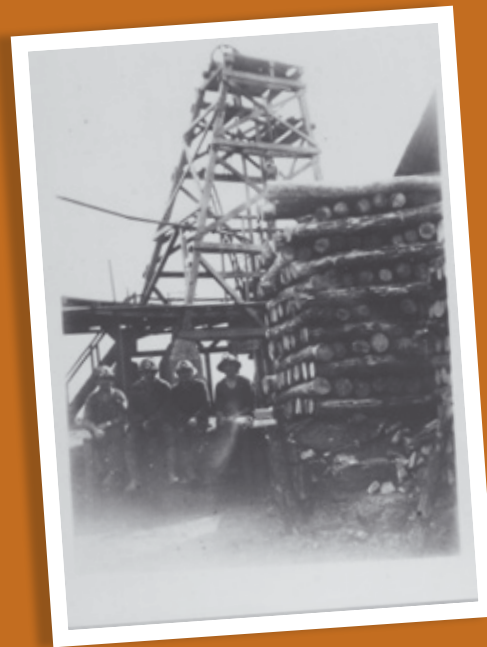
Le chevalement original - The original headframe
