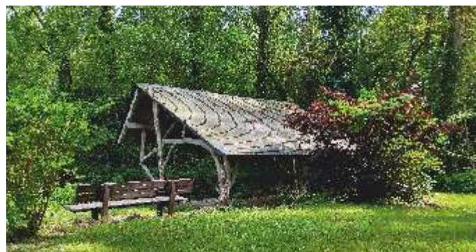
Lavoir du Ponceau
