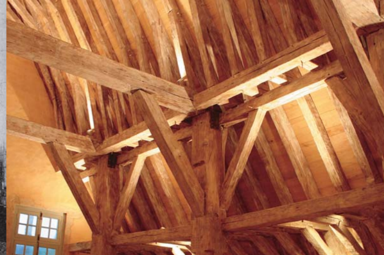
Charpente en chêne des halles, restaurée en 2006-2007.
