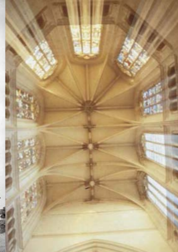
Eglise Notre-Dame-des-Marais, voûte du chœur, terminée vers 1596.
