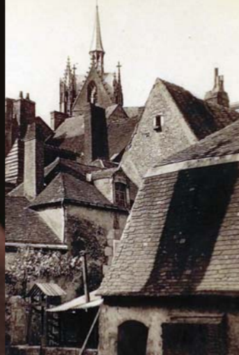
Maisons anciennes entre le bras de rivière du Pavillon et la rue Delaborde, détruites progressivement à partir de l'entre-deux guerres.
